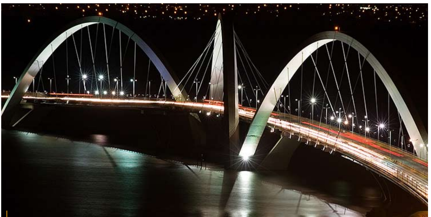
■ Ponte JK é considerada um monumento de arquitetura e engenharia de Brasília. A capital federal recebe o maior encontro de engenheiros do mundo
